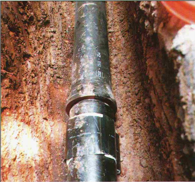
Die Muffenverbindungen werden bei FZM-Gussrohren entweder mit Gummimanschetten, oder mit Raychem-Schrumpfschläuchen geschützt. Im Bild hat der Verleger den Schrumpfschlauch vor dem Erstellen der Verbindung auf das Spitzende aufgezogen und wird ihn nun in einem zweiten Arbeitsgang über die Muffe ziehen und dort schrumpfen. Deutlich erkennt man die aggressiven Bodenverhältnisse im Grabenbereich, vor denen der FZM-Panzer das Gussrohr auch ohne Kieskoffer zuverlässig schützt.
