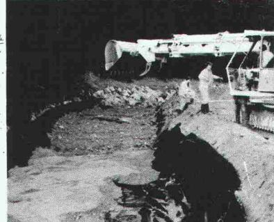
MONARFLEX Geomembranen liefern wir in Rollen von 4 x 25 m ab Lager oder fertig vorkonfektioniert.
