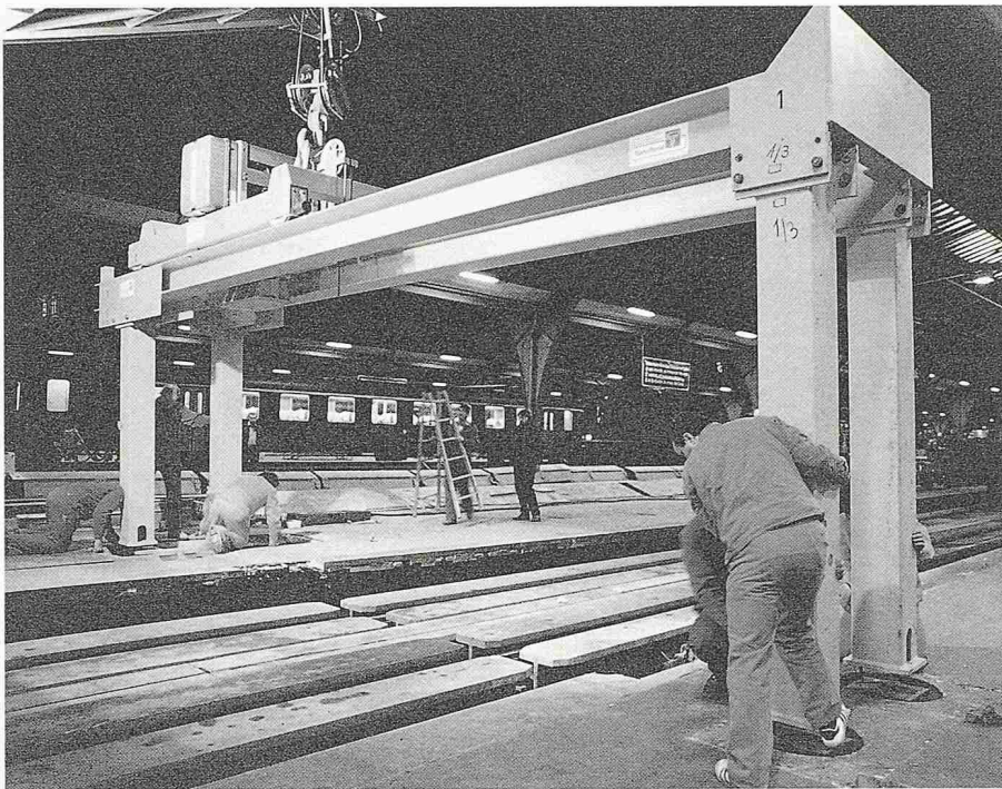
Bild 4. Aufstellen des Portalrahmens
