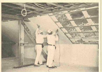
gepackt in einen Mantel aus nichtbrennbarem Glasflies, wiegt in einer Dicke von 15 mm oder 20 mm nur 11,3 bzw. 15,5 kg/m<sup>2</sup>. Fireboard eignet sich zum Bekleiden von Decken, Wänden, Stahlträgern, Stahlstützen, zum Dachgeschossausbau oder für Schachtwände. Überall ist der Schutz zuverlässig. Alle Fireboard-Konstruktionen sind geprüft und ihr Feuerwiderstand durch Versuche oder Gutachten nachgewiesen.
