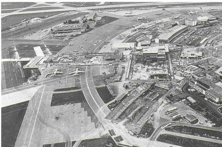
Bild 2. 1973 glich der Flughafen während der dritten Ausbauetappe einer riesigen Baustelle. Terminal, Findexdock und Parkhaus B wachen empor, die Baugrube der SBB-Flughafenlinie (im Vordergrund) liegt noch offen da
