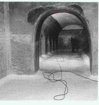
Wasserreservoir Muttenzerwald: Kombination von verschiedenen Sanierungs-Methoden: Injektionen gegen eindringendes Wasser und zur Verfestigung des Gewölbes, Auskleidung durch starre Abdichtung.
