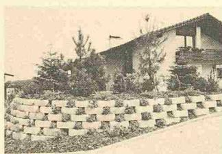
Die Steine werden trocken verlegt, in engem oder weitem Abstand. Die durchdachte Formgebung ermöglicht einen individuellen Aufbau der Mauer mit verschiedenen Neigungen, Ecken, Kurven. Aufgrund des leichten Gewichtes kann der Seconde-Stein auch vom Hobbygärtner mühelos versetzt werden. Das mit Boden ausgebildete und nach hinten offene Element erlaubt das Verwurzeln der Bepflanzung mit der Hinterfüllung und bildet somit eine gute Vegetationsgrundlage.
