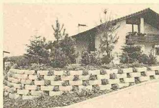
Die Steine werden trocken verlegt, in engem oder weitem Abstand. Die durchdachte Formgebung ermöglicht einen individuellen Aufbau der Mauer mit verschiedenen Neigungen, Ecken, Kurven. Aufgrund des leichten Gewichtes kann der Seconde-Stein auch vom Hobbygärtner mühelos versetzt werden. Das mit Boden ausgebildete und nach hinten offene Element erlaubt das Verwurzeln der Be pflanzung mit der Hinterfüllung und bildet somit eine gute Vegetationsgrundlage.
