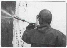
Mit den neuen Hammelmann Höchstdrucksystemen erzielen Sie Betriebsdrücke bis 2000 bar <u>am</u> Sanierungsobjekt. Und darauf kommt es an.
