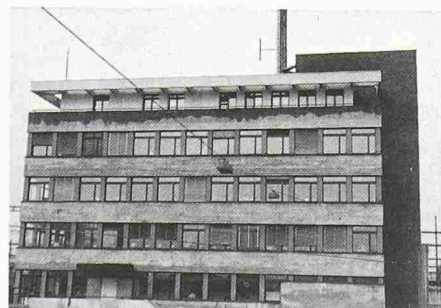
Bild 1. Gebäude-Ansicht. Die Stahlbetonstützen zwischen den Fensteröffnungen müssen auch den Stockwerk-Schub aus Windlasten aufnehmen. Diese Stützen bilden zusammen mit den Geschossdecken eine relativ biegeeweiche Rahmenkonstruktion
