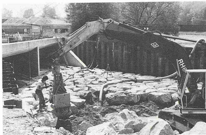
Bild 6. Ablaufkanal: Auslauf in die Limmat
