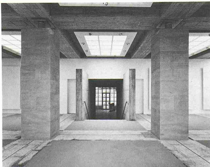
Übergang Altbau/Annexbau Süd
