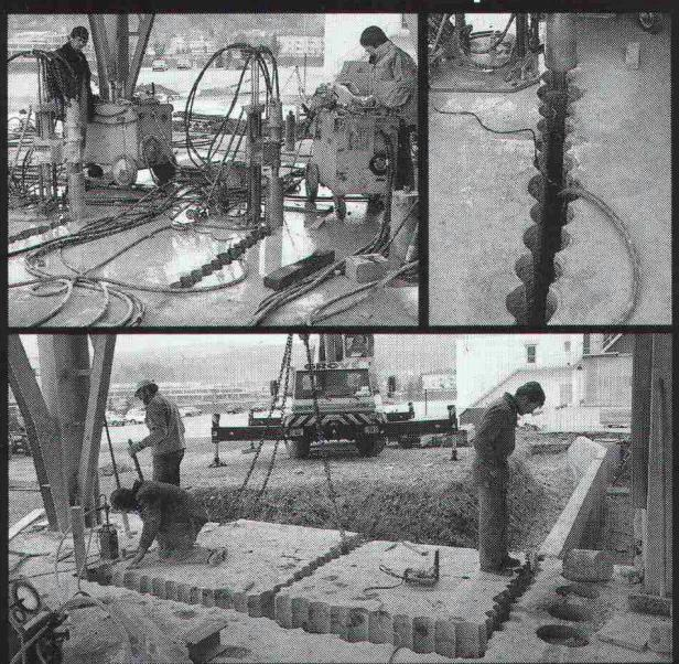
Der Ausbruch einer stark armierten 90 cm tiefen Beton-Fundamentplatte konnte nur mit Reihenbohrungen ausgeführt werden.
