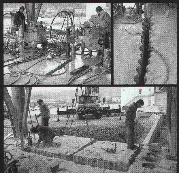
Der Ausbruch einer stark armierten 90 cm tiefen Beton-Fundamentplatte konnte nur mit Reihenbohrungen ausgeführt werden.
