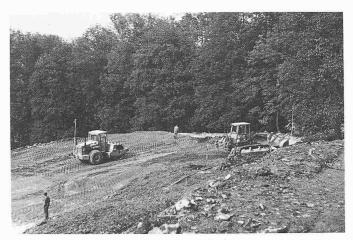
Bild 5. Schüttarbeiten in einer Wendeplatte
