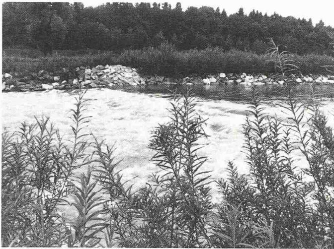
Eine Naturstein-Sohlenrampe in der Thur bei Pfyn/Hüttlingen sichert einen kleinen Absturz mit einem Höhenunterschied von 80 cm
