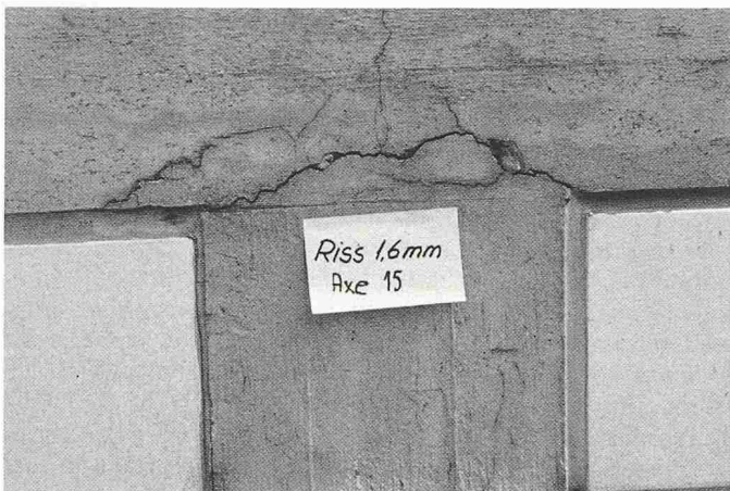
Bild 5. Verformungsriß im Übergang Stütze-Decke. Spannweite l = 13,2 \text{ m} ; Deckenstärke d = 35 \text{ cm} \triangleq 1/38 ; Durchbiegung \delta = 50 \text{ mm} \triangleq 1/270 . Baujahr 1966
