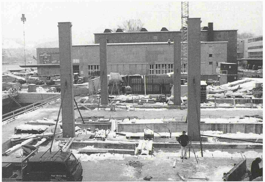
Bild 2. Montage der Hochbaustützen in den Gleiswannen, noch ohne Knautschzone
