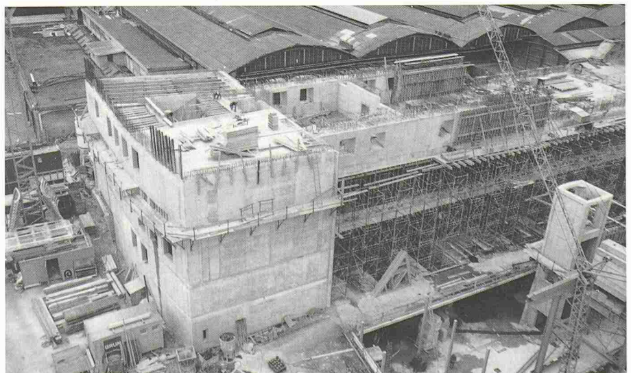
Bild 11. Kasten des Brückenquerschnitts im Bauzustand (Foto E. Kneubühler, Kriens)
