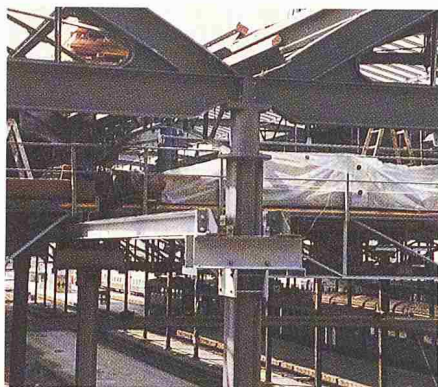
Bild 4. Nördliche Hallenverlängerung mit Schutz- und Arbeitsbühne
