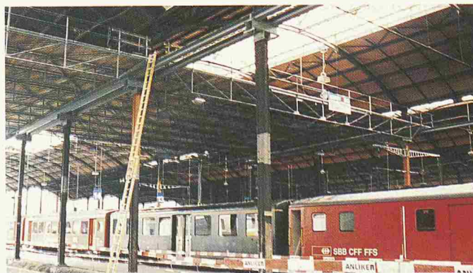
Bild 3. Schutz- und Arbeitsbühne über den Gleisen
