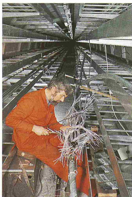
Bild 3. Monteur beim Spleissen eines Fernmeldekabels 100×4×0,6 im Kabelstollen
