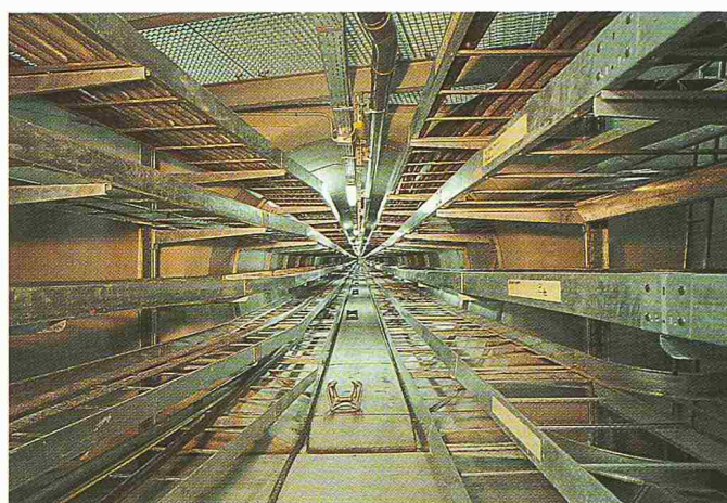
Bild 2. Blick in den Kabelstollen (Montagezustand)
