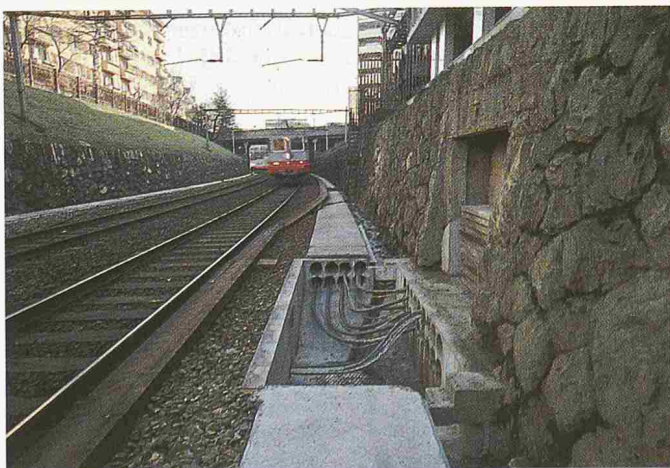
Bild 2. Rohrblock unterhalb der Hauptschaltanlage des Bahnhofs Luzern
