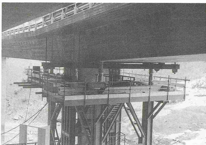
Bild 5. Hebung der Träger
