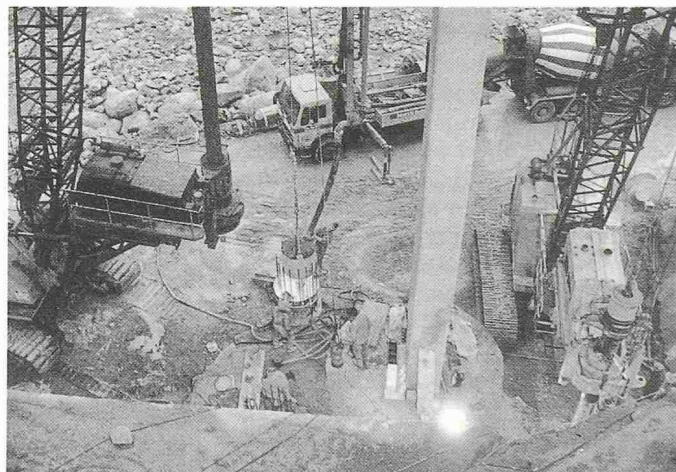
Bild 3. Verfestigung der Foundation
