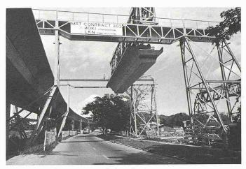
Bild 3. Brückenträger wird über die Strasse transportiert
