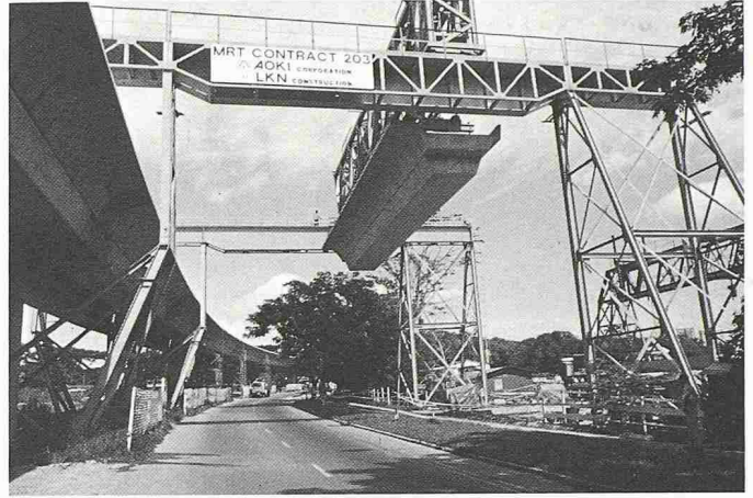
Bild 3. Brückenträger wird über die Strasse transportiert
