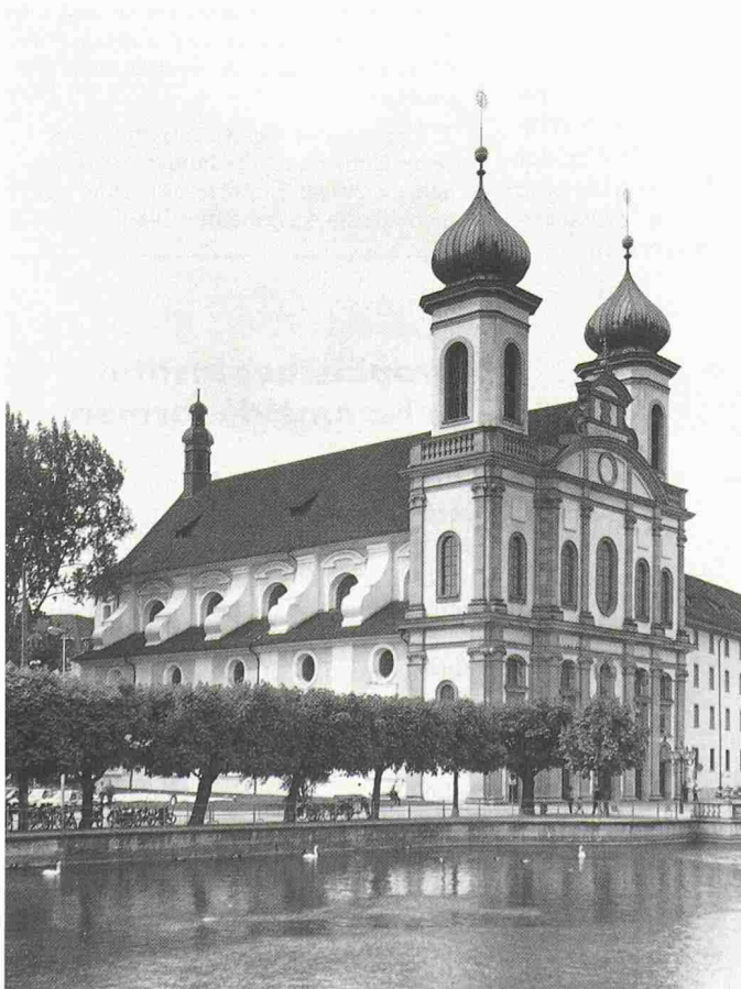
Blick von Nordosten auf die Luzerner Jesuitenkirche am Reussufer
