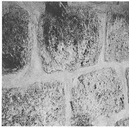
Bild 5. Gesundes Quadermauerwerk sollte nicht verputzt werden. Der Fugenmörtel muss aber rissfrei an die Steinflächen anschliessen
