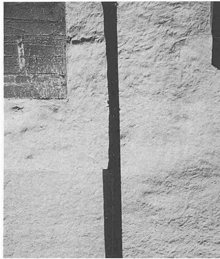
Bild 14. Abgesackter Verputz, gestrichen. (Schloss Holligen, Bern 1982)
