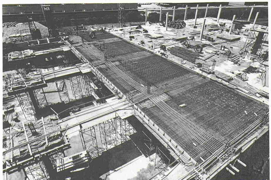
Bild 6. Ansicht einer Betonieretappe 15,40×56,40 m (ohne obere Armierung)
