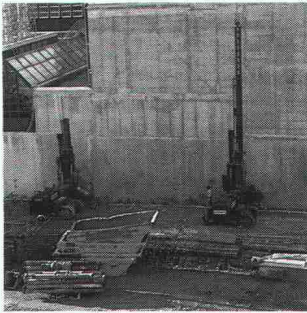
Modernste Bohrmaschinen beim Ausführen der Hochdruck-Injektionswand
