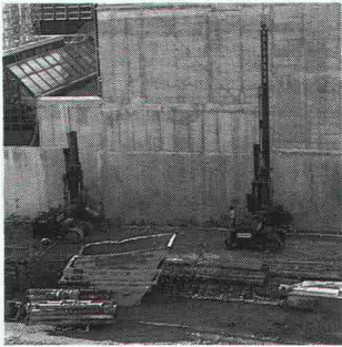
Modernste Bohrmaschinen beim Ausführen der Hochdruck-Injektionswand
