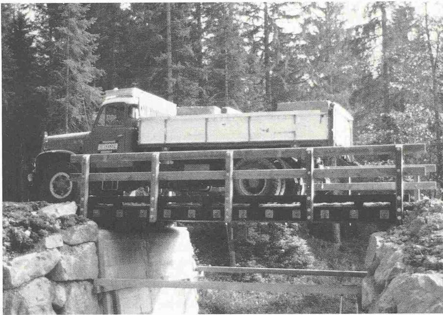
Bild 3. Brücke für Walderschliessungsstrassen
