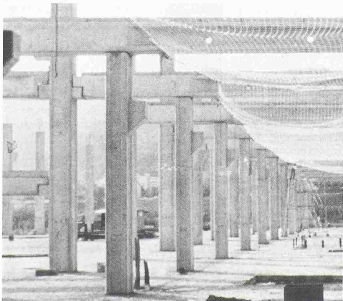
Auf einer Grossbaustelle werden Auffangnetze montiert (Bild: SUVA)
