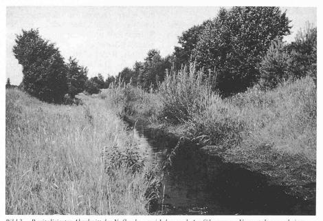
Bild 3. Revitalisierter Abschnitt des Nefbachs, zwei Jahre nach Ausführung von Umgestaltungsarbeiten
