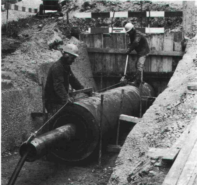
**Unterquerungen****Rammvortriebe**mit Stahlrohren  $\varnothing$  16 – 100 cm**Hydraulische Pressvortriebe**mit Betonrohren  $\varnothing$  100 – 400 cm
