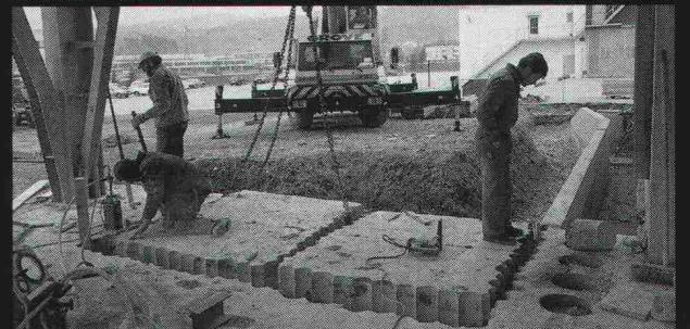
Der Ausbruch einer stark armierten 90 cm tiefen Beton-Fundamentplatte konnte nur mit Reihenbohrungen ausgeführt werden.
