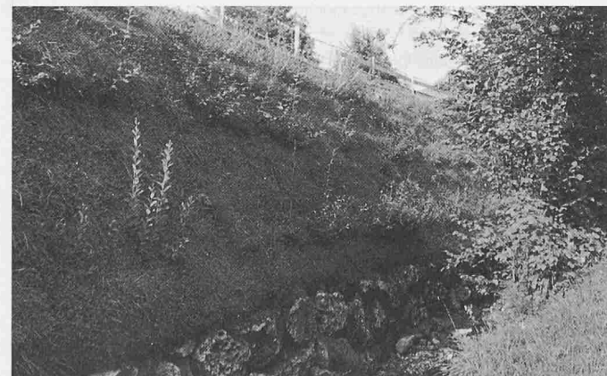
Bild 19. Geotextilarmierte Stützkonstruktion (System Textomur) mit Stützgitter als Einbauhilfe, Rohbauzustand
