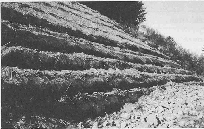
Bild 6. Rutschverbauung mit «Polsterwand», Begrünung mit Buschlagen
