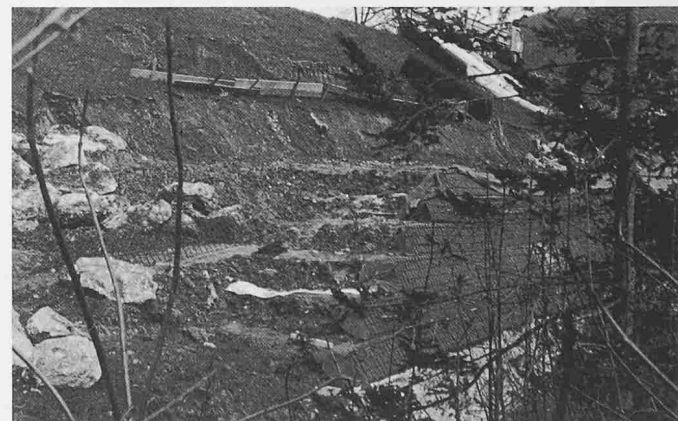
Bild 20. Gleiche Konstruktion etwa 4 Monate nach der Begrünung mit Spezialhydropsaat und Buschlagen
