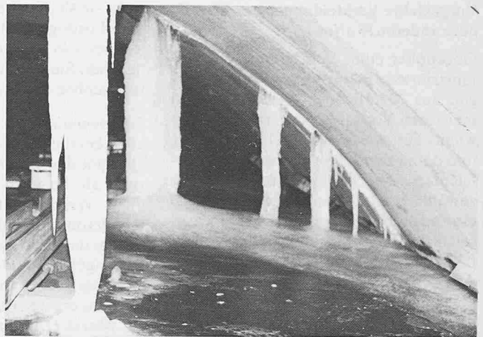
Bild 3. Eisbildung im Kalottenbereich (Frischlufthkanal) und auf der Zwischendecke infolge fehlender Isolation
