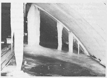
Bild 3. Eisbildung im Kalottenbereich (Frischluftkanal) und auf der Zwischendecke infolge fehlender Isolation
