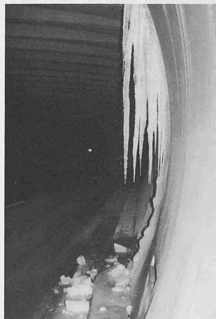
Bild 1. Eisbildung infolge Wassereintritts durch Fugen und Risse wegen fehlender Isolation
