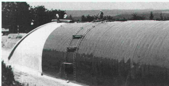
Tunnel (Nordumfahrung Zurzach) – zur Zeit in Ausführung: abgedichtet mit 30 000 m 2 Sarnafil Typ FP 4 mm.
