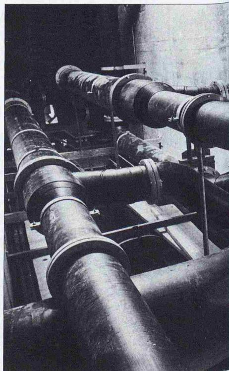
Gussrohre sind nach wie vor Hauptträger der Schweizerischen Gas- und Trinkwasserversorgung. Insgesamt liegt ein Netz von 37'000 Kilometern in unserem Boden. Die moderne Generation duktiler Gussrohre und Formstücke mit Polyurethan-Innenauskleidung Von Roll ducpur empfiehlt sich besonders aufgrund der rationellen Verbindungs- und Verlegemöglichkeiten sowie der hervorragenden Materialeigenschaften.
