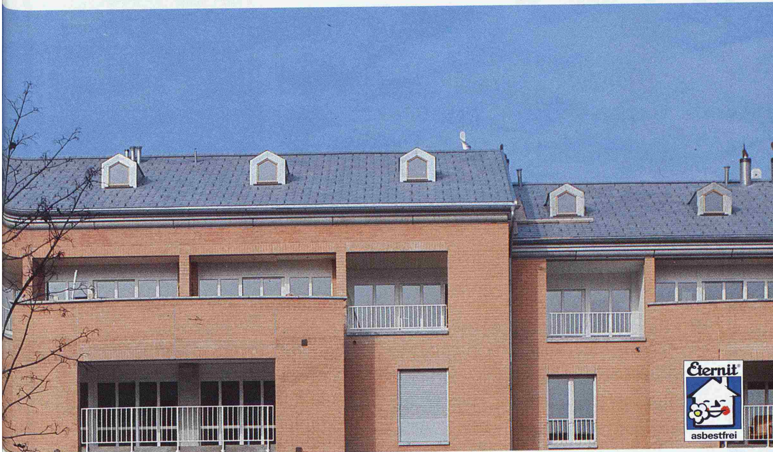
Mehrfamilienhaus «Habitat», 8957 Spreitenbach. Architekt Urs Fischbacher, Dachdecker P. Wiederkehr
