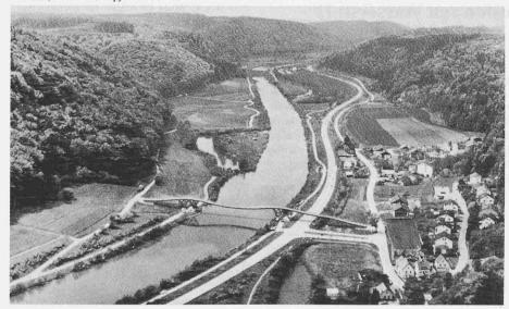
Für den Bauherrn und auch für den Architekten war es von Beginn an klar, dass diese Brücke der Landschaft zuliebe aus Holz erstellt werden sollte (Bild 1). Man suchte nach einer neuen und zeitgemässen Form, welche aus Konstruktion und Statik heraus zu entwickeln war. Die Antwort lautete: ein Spannband. Dieses Spannband, bestehend aus neun dicht nebeneinanderliegenden, 65 cm hohen und 22 cm breiten, je 192 m langen Balken aus Brettschichtholz, bildet das eigentliche Tragwerk.
