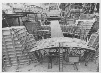
Blick in Richtung Hirschengrabentunnel: Auf dem Niveau des unterirdischen Ladengeschosses sind Gerüst und Verschalung eines Betonträgers für das Perron von Gleis 1 und 2 zu erkennen. Der hintere Träger ist bereits betoniert. Die Vertiefung im oberen Teil wird die neuen Schienenstränge und den Schotterbelag aufnehmen (Fotos: Comet)
