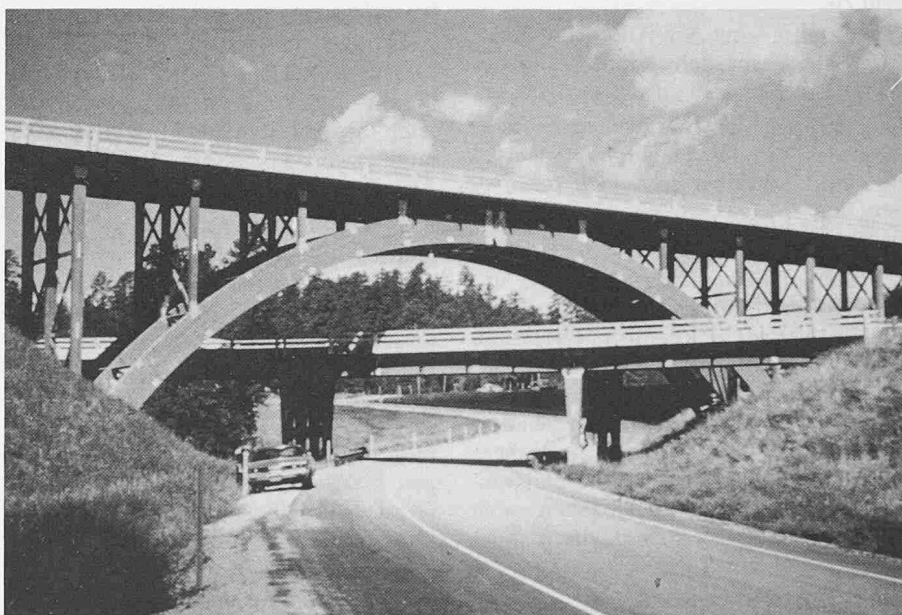
Selbst relativ grosse Brücken, wie diese Highway-Überführungen in Keystone, Wyoming/USA, lassen sich aus Brettschichtholzkonstruktionen erstellen, wenn ein wirksames Holzschutzkonzept angewandt wird
