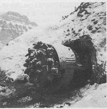
Bild oben rechts: Als erstes Teilstück der Walenseeautobahn wurde im April 1986 auf Glarner Seite der Kerenzerbergtunnel eröffnet. Begonnen wurde mit dem Bau des 5,7 km langen, zweispurigen Tunnels im Jahr 1979 (Foto: Comet)
