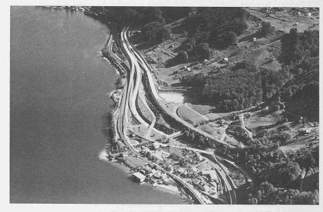
Der Anschluss Murg, an der Kantonsgrenze St. Gallen/Glarus gelegen, verbindet die Autobahn mit den Ortschaften am See und dem Kerenzerberg. Es galt bei diesem Anschlusswerk, die grosse Höhendifferenz zwischen den beiden Fahrbahnen der N3 zu überwinden, und dies in steilem Gelände und bei gedrängten Platzverhältnissen (Foto: Comet)
