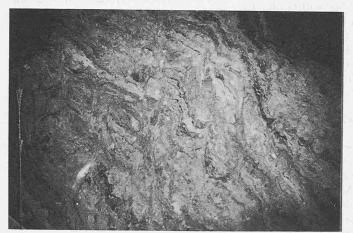
Bild 5. Rheingletschermoräne, sehr kompakt gelagert mit Abbauspuren
