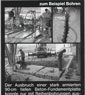
konnte nur mit Reihenbohrungen ausgeführt werden.
