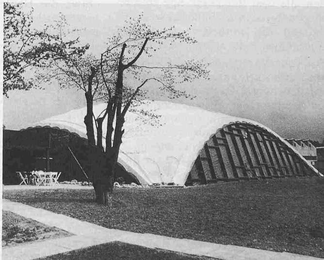
1982 entstand die Tennishalle in Teufenthal AG. In der Sommersaison bleiben die Seitenwände offen (Bilder: Lignum)
