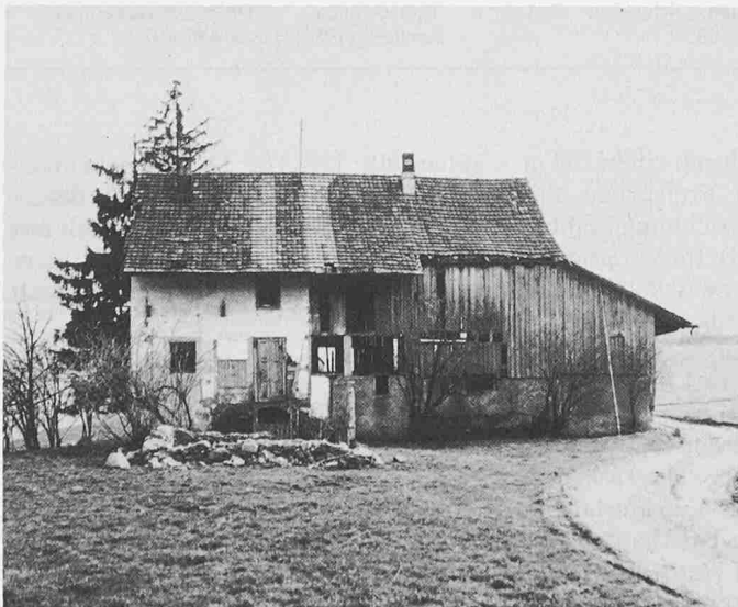
Alte Häuser müssen nicht immer dem Abbruchhammer zum Opfer fallen
