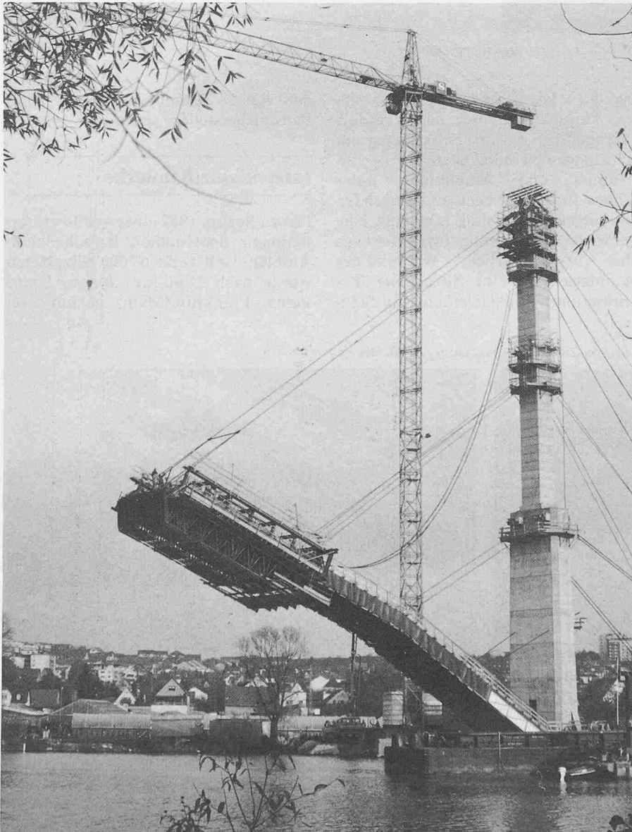
Bild 8. Zweigleisige Eisenbahnbrücke in Veitshöchheim für die Neubaustrecke Hannover-Würzburg. Herstellen des Bogens im Freivorbau mit Abspannungen zu Hilfspylonen.
