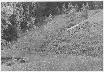
Bild 12. Luftseitige Ansicht des Dammes am Sülibach ZH mit den 1984 erlittenen Auswaschungen (Foto des Autors)
