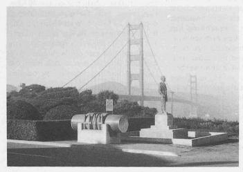
Bild 5 (links). Golden Gate Bridge. Im Vordergrund Detail des Kabelquerschnittes ( $\oslash$  92 cm) und Statue von Joseph B. Strauss
