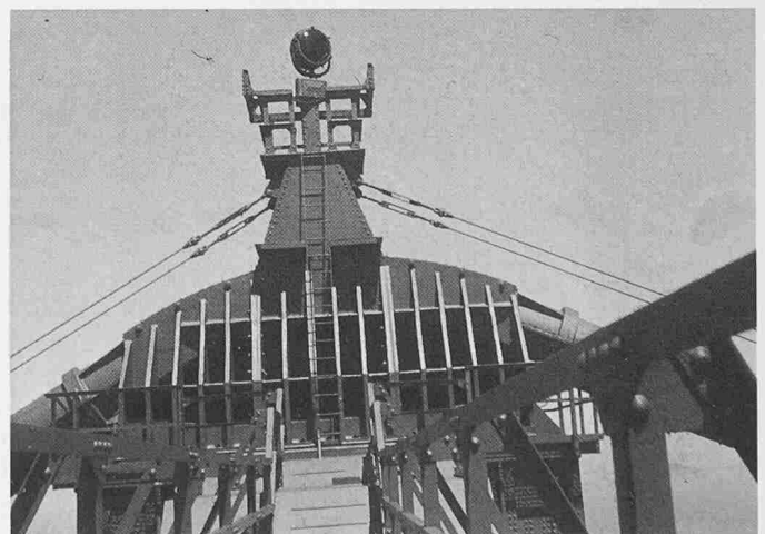
Bild 7 (unten). Kabelsattel auf dem Nordtower
