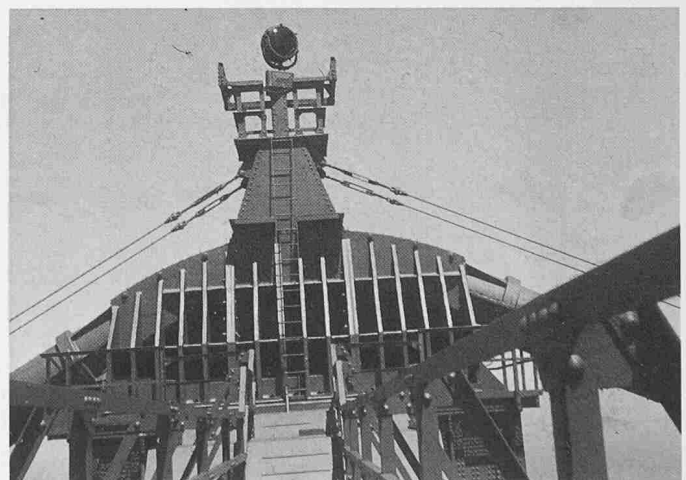
Bild 7 (unten). Kabelsattel auf dem Nordtower
