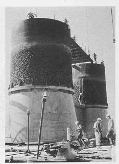
Bild 10. Dumbell mit aufgeschraubtem Kofferdam vor dem Versetzen
