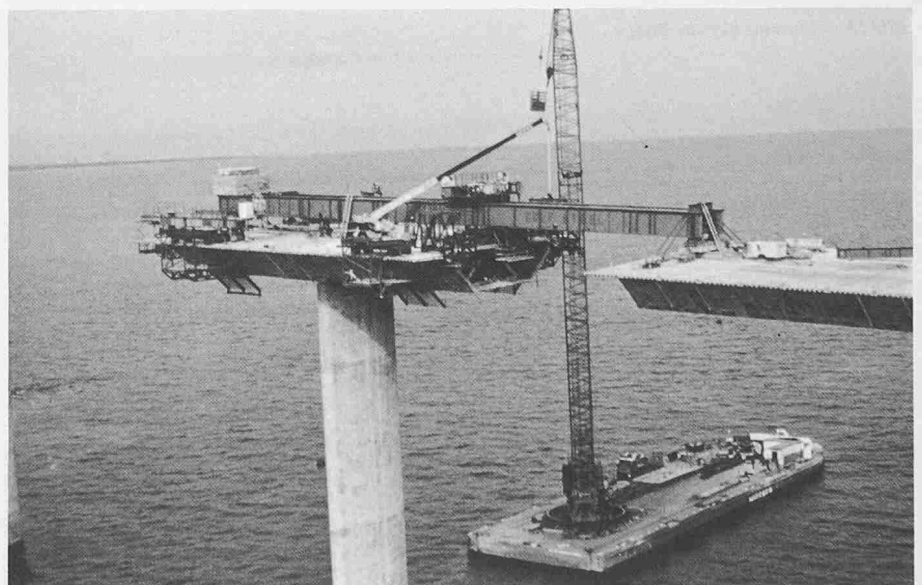
Bild 9. Balanced-Cantilever-Verfahren mit Plattenträger und Beam & Winch
