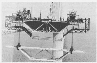
Bild 2. Heben eines grossen Hohlkastensegmentes mit «Beam and Winch»
