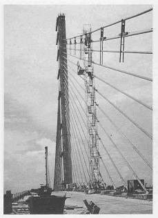
Installierte Schrägseilkabel mit Gerüstturm für das Zusammenschweissen der Hüllrohre
