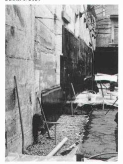
filterstabilen Sickermatte Enkadrain, die überall dort eingesetzt wird, wo aus bautechnischen und wirtschaftlichen Gründen ohne Raumverlust gegen das Terrain (Fels, Rühlwand usw.) betoniert wird. Enkadrain CK besteht aus
