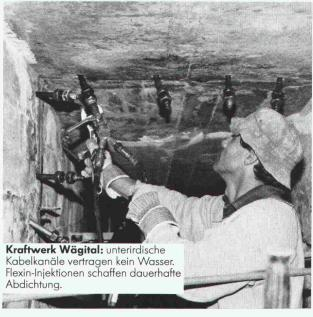
Für das Abdichten von Rissen, Fugen und undichten Stellen an neuen und alten Betonbauten sind Renesco-Flexin-Injektionen die sicherste Methode, unter allen Umständen. Flächenabdichtungen nach dem Renesco-Vandex-System schaffen trockene Untergeschosse, selbst wenn das Haus im Grundwasser steht.
