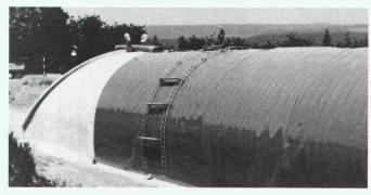
Tunnel (Nordumfahrung Zurzach) – zur Zeit in Ausführung: abgedichtet mit 30 000 m² Sarnafil Typ FP 4 mm.
