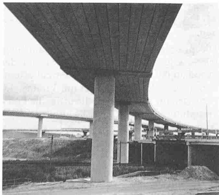
Bild 1. Autobahnkreuz Leidschendam mit Überbauten aus 34,50 m langen Spannbeton-Fertigteilträgern und 53 Betonpfahlstützen erstreckt sich über vier Ebenen und ist 21 m hoch
