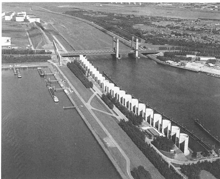
Bild 2 (rechts). Windschirm für die Schifffahrt im Europoort Rotterdam aus 49 Wandplatten 15/10/0,30 m (Nordteil), 58 Halbschalen 25/40/0,25 m (Mittelteil) und 22 Halbschalen 25/180/0,25 m aus Ortbeton (Südteil) - gegründet auf Spannbetonpfählen
