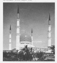
ser von 50 m, den Ringbalken darunter, das untere Dach, die 120 m hohen Minarettürme und 80 riesige Türen mussten allein mehr als 3000 verschiedene (insgesamt ca. 20000 Paneele) Stahlplatten - ungleiche Dreiecke und Quadrate - angefertigt werden, eine Arbeit, die ein Höchstmass an Präzision verlangte. Per Laserstrahl wurden die einzelnen Elemente geschnitten und millimetergenau eingepasst.
