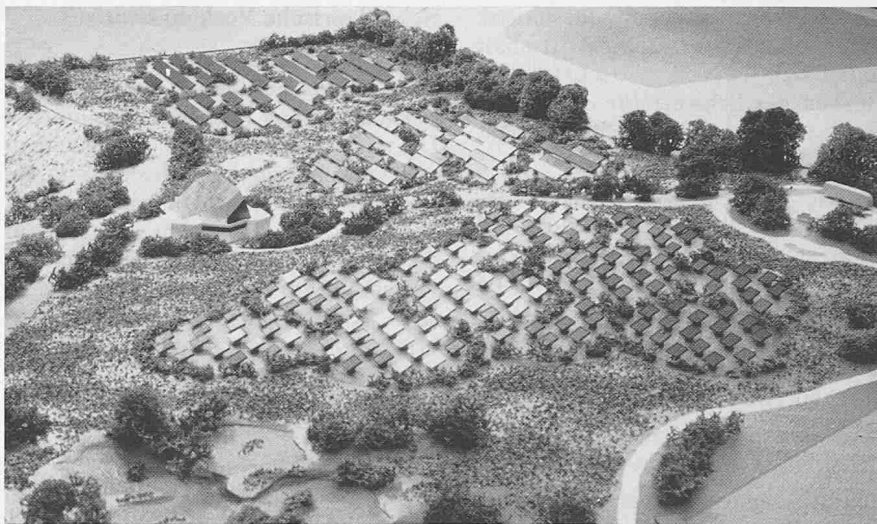
Die 50 000 m 2 Gelände umfassende 300-kW-Anlage Kobern-Gondorf im Modell: links vor dem Solarzellenfeld die Schaltzentrale, links unten Teiche des Biotops (Modellaufnahme RWE/Quelle: SEV/VSE Bulletin 16/87)
