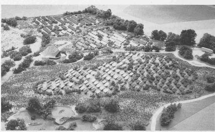
Die 50 000 m² Gelände umfassende 300-kW-Anlage Kobern-Gondorf im Modell: links vor dem Solarzellenfeld die Schaltzentrale, links unten Teiche des Biotops (Modellaufnahme RWE)(Quelle: SEV/VSE Bulletin 16/87)
